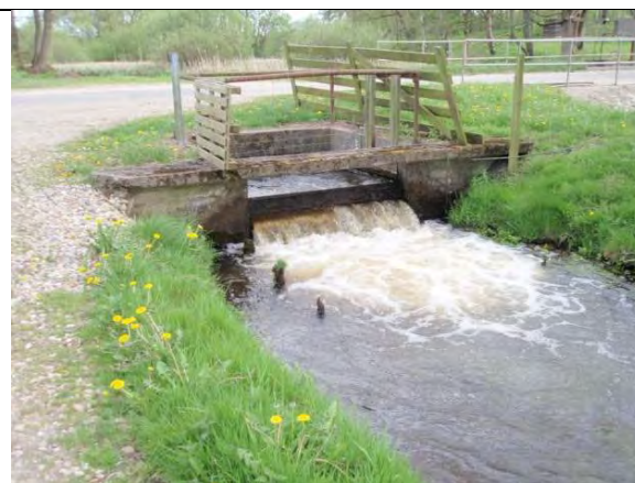
Udløb fra underføringen
