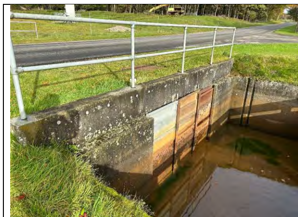
Indløb til underføringen
