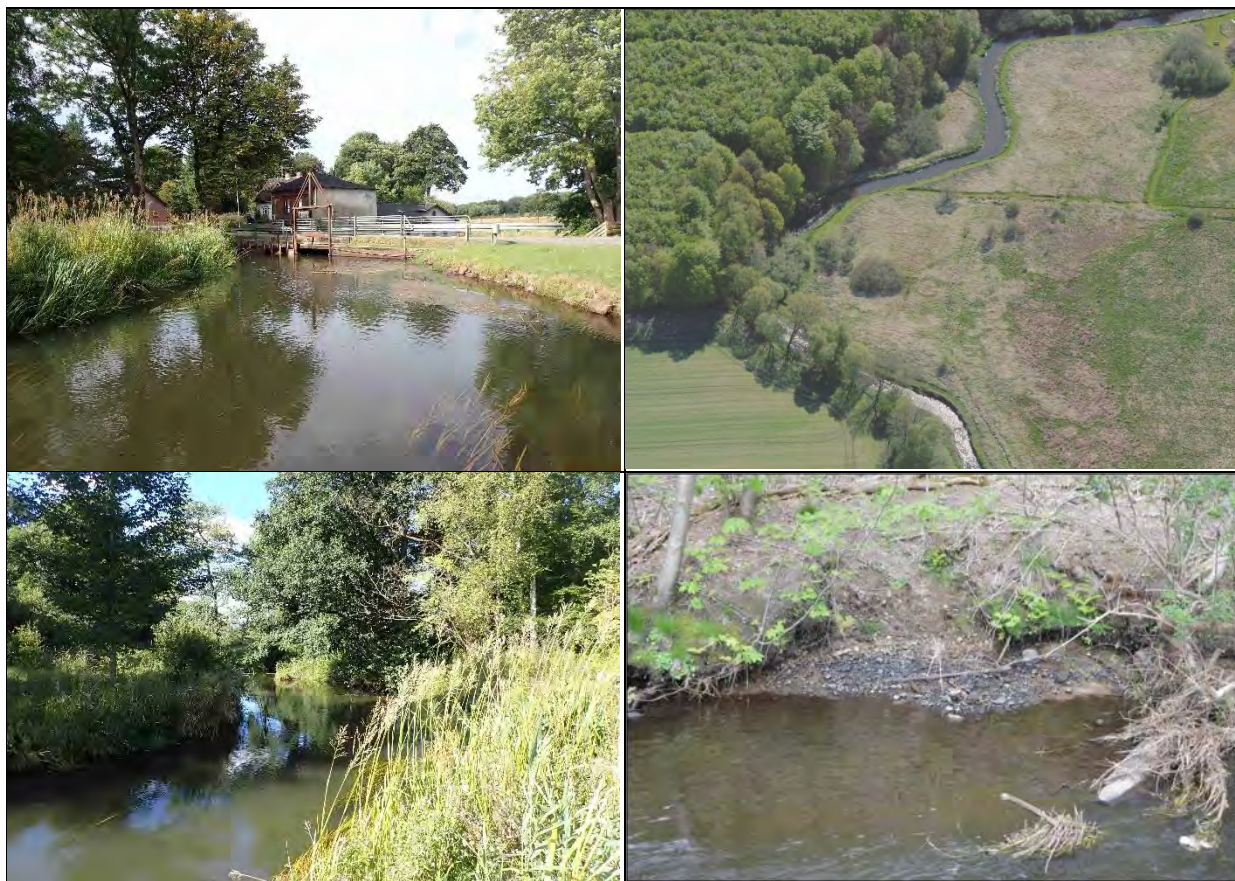
Figur 3 Øverst tv.: Vejbro og stemmeværk ved Hulkær Fiskeri (LandSyd, 2022). Øverst th.: Holsted Å er et naturligt mæandrerende vandløb i tæt kontakt med de omgivende enge i ådalen (Klimadatastyrelsen, 2023). Nederst tv.: Opstuvningszonen i Holsted Å 420 meter opstrøms Hulkær Fiskeri (LandSyd, 2022). Nederst th.: Aflejringer af naturligt forekommende stenmaterialer ved bredden af Holsted Å
