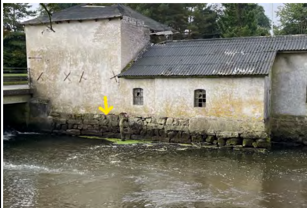
Figur 16 - Stenfundament som bevares
