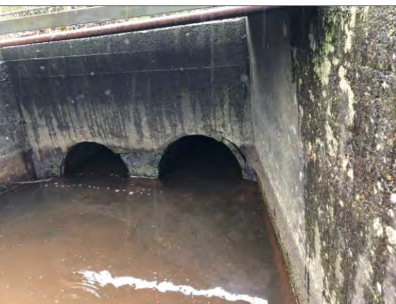
Udløb fra underføringen
