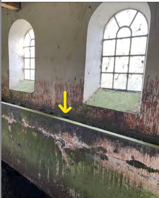
Figur 17 - Betonkanal som bevares sammen med stenfundamentet
