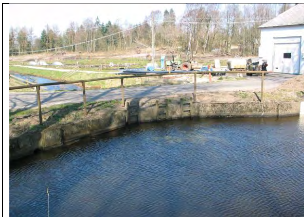
Indløb til underføring
