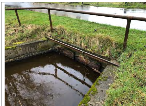
Indløb til underføring
