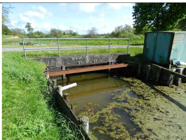
Udløb fra underføringen
