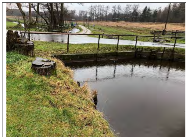
Indløb til underføringen
