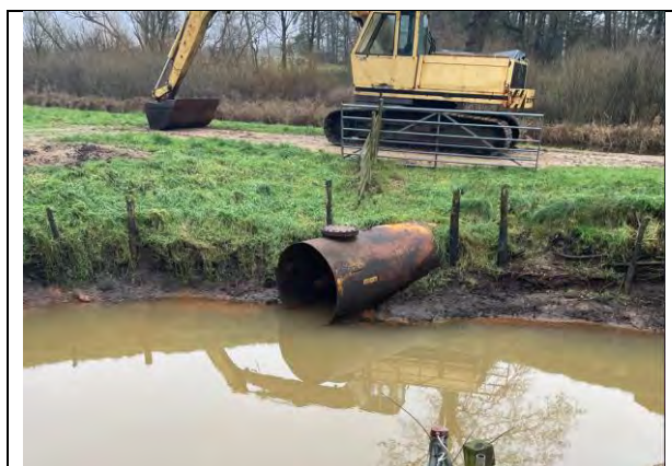
Indløb til underføring
